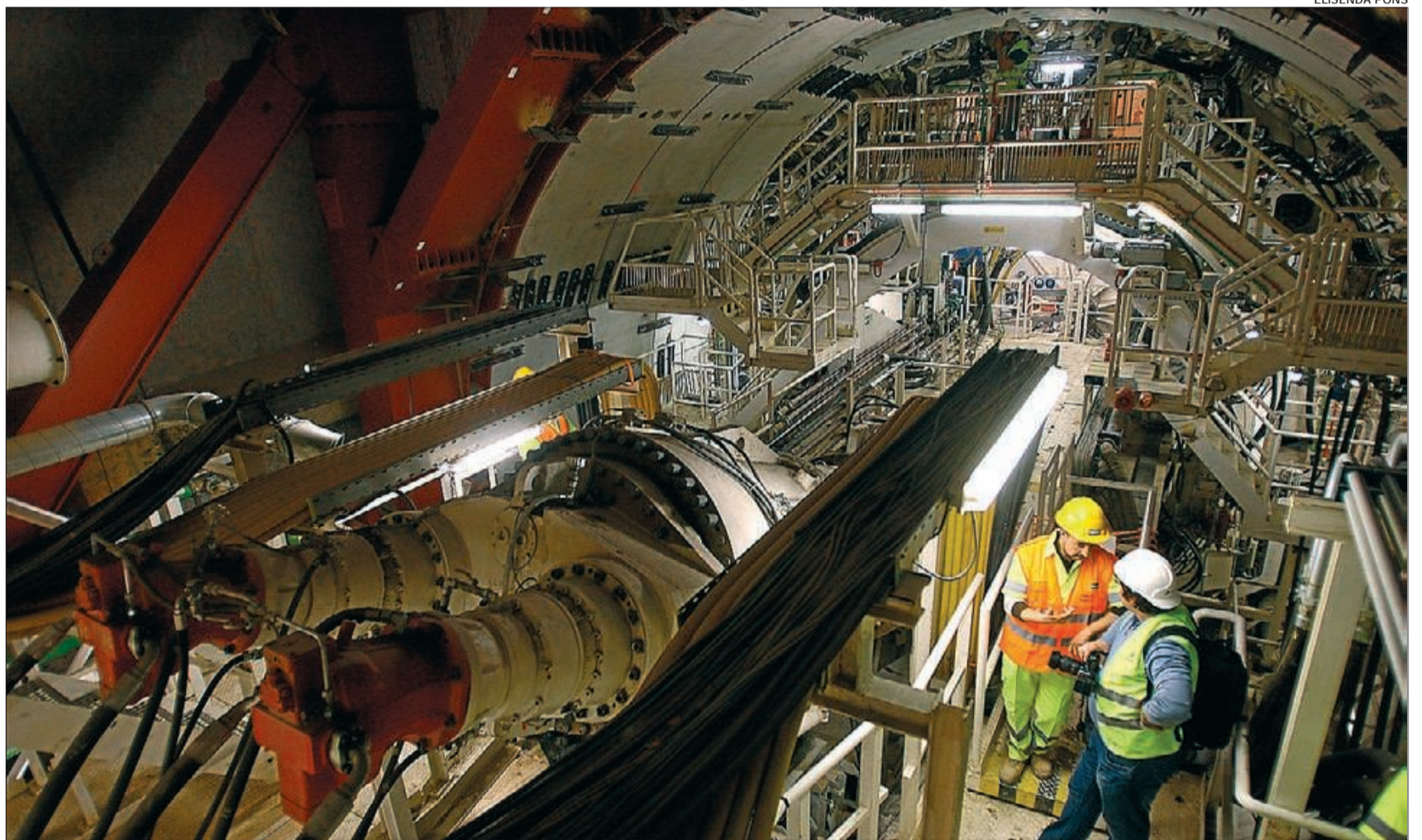
33 Zona de cap de la tuneladora Bàrcino, que ahir va començar a perforar el túnel de l'AVE al pou d'atac construït a la cruïlla Mallorca-Biscaia.
