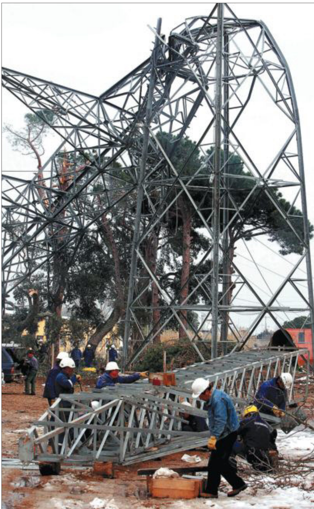
Un grupo de operarios reparaban una torre de alta tensión en Platja d'Aro. / PERE DURAN
