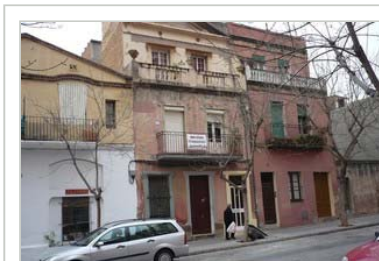
Una imatge d'alguns dels edificis que estan en procés de quedar desafectats, al carrer del Pintor Tapiró. Foto: V. P.
