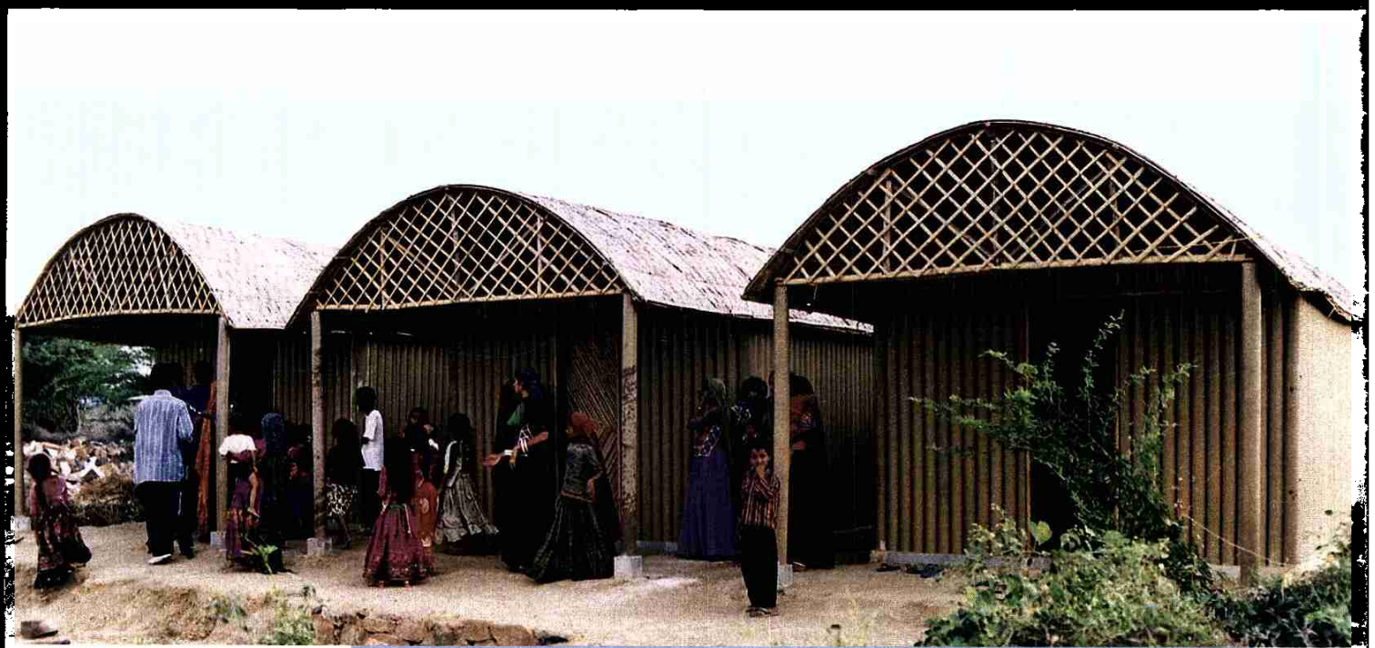
ÚTIL Y ECONÓMICO. Arriba, viviendas diseñadas en India por Shigeru Ban con tubos de cartón. Abajo, puente de cartón ideado por el arquitecto e instalado en Vers-Pont-du-Gard, en el sur de Francia.
