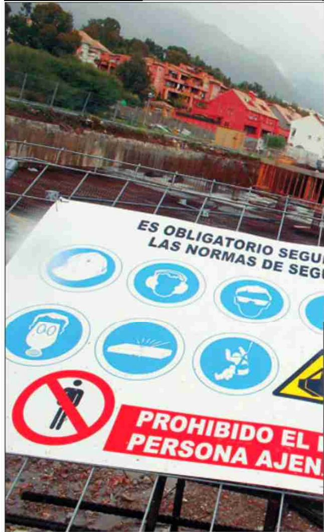
▶▶ Construcción de nuevas viviendas en un solar de Marbella, el viernes.
